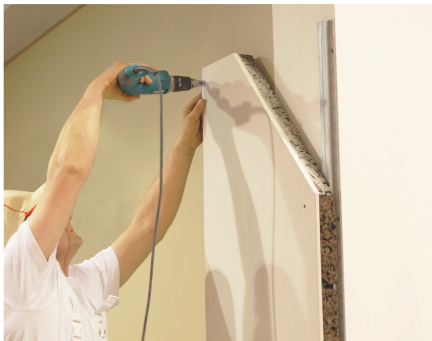
Figura 3. Aplicação da placa composta de gesso laminado com isolamento incorporado em aglomerado de cortiça expandida
