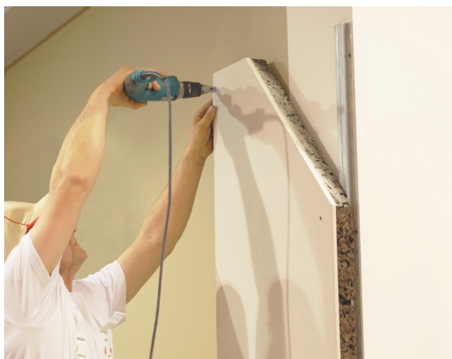
Figura 2: Aplicação da placa composta de gesso laminado com isolamento incorporado em aglomerado de cortiça expandida
