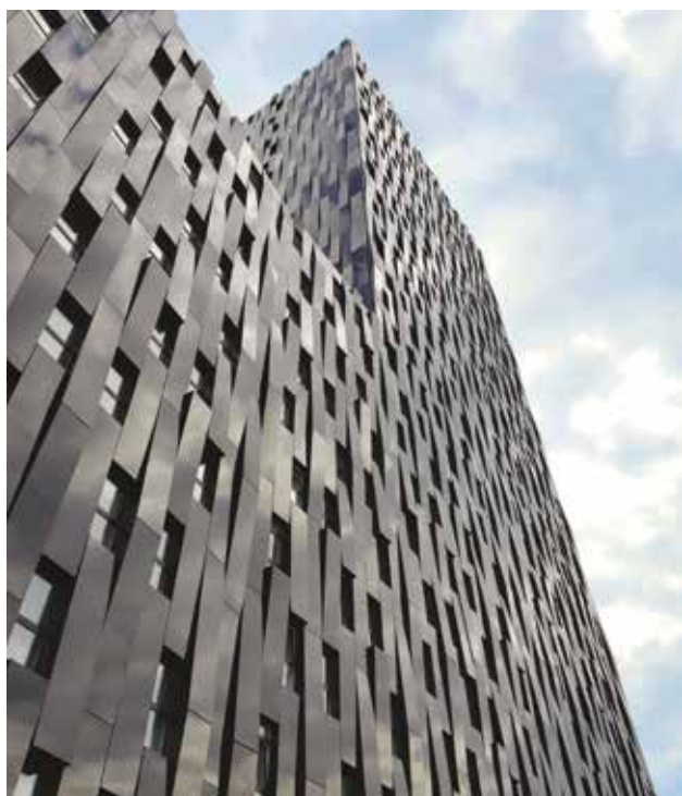
TORRES DE BOLUETA Construção Passivhaus mais alta do mundo Bilbao, Espanha
