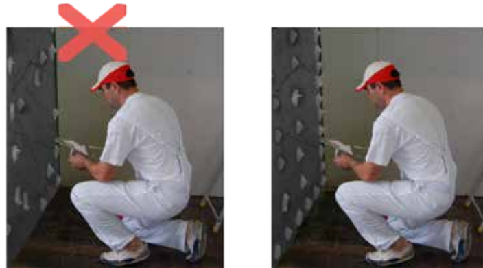
Figura 89: Aplicação da cola.
