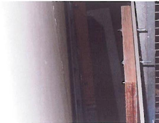
**Figura 19:** Reforço com uma placa de contraplacado de madeira na zona de aplicação das cargas excêntricas.
