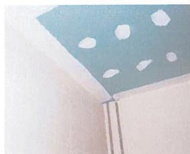
**Figura 30:** Placa H (hidrófuga).
