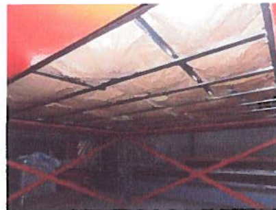
Figura 6: Montagem da solução 4 de reabilitação/reforço, sob a laje aligeirada de vigotas pré-esforçadas e abobadilhas cerâmicas.
