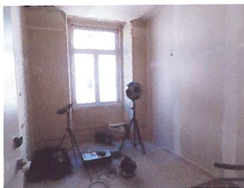
Figura 10: Medição do isolamento sonoro a sons aéreos entre compartimentos.
