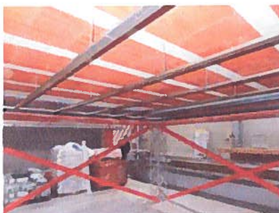
Figura 6: Montagem da solução 4 de reabilitação/reforço, sob a laje aligeirada de vigotas pré-esforçadas e abobadilhas cerâmicas.
