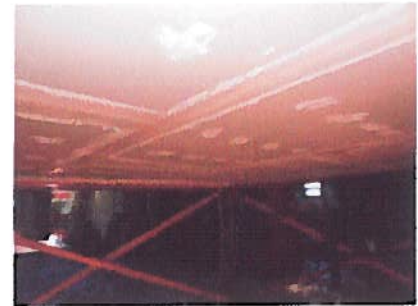
Figura 6: Montagem da solução 4 de reabilitação/reforço, sob a laje aligeirada de vigotas pré-esforçadas e abobadilhas cerâmicas.
