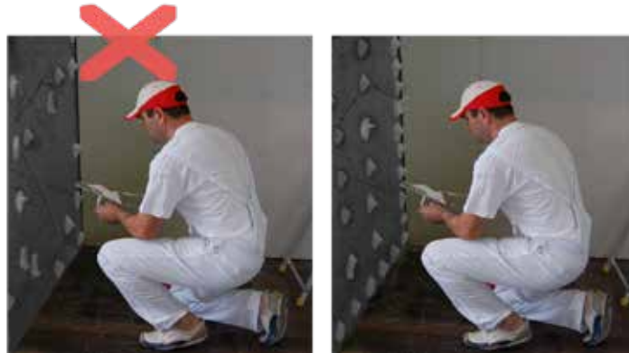
Figura 89: Aplicación de la pasta de agarre.
